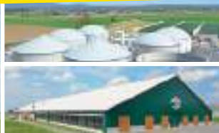
RÉSERVOIRS EN BÉTON ARMÉ
