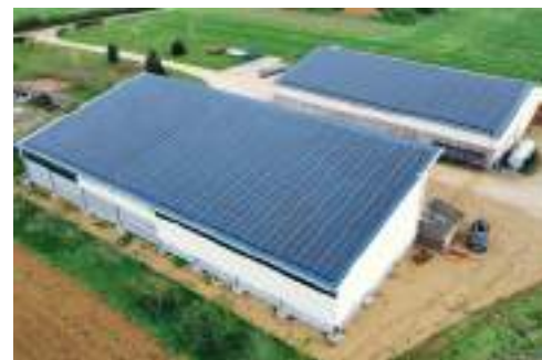
INSTALLATION PHOTOVOLTAÏQUE EN TOITURE 750 KWC
