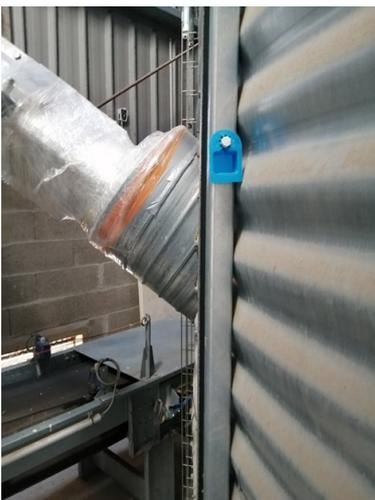
**Figure 3 : Positionnement d'un diffuseur Exosex SP TAB sur la paroi externe d'une cellule (diffuseur bleu avec pastille de poudre à phéromones)**
