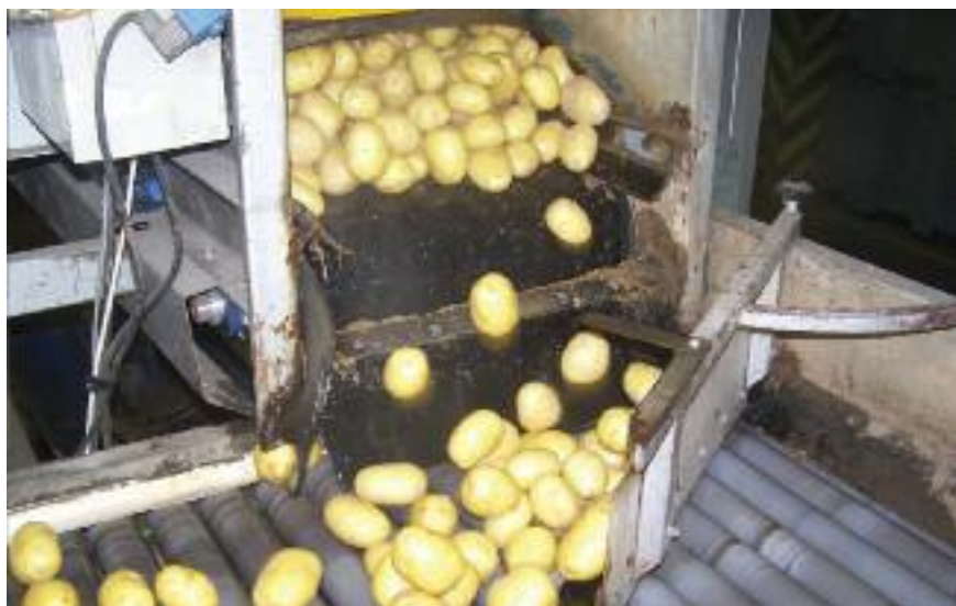
➤ La mise en œuvre de l'expertise Muni-LIS® permet de diagnostiquer les zones à risque des chaînes de conditionnement.
