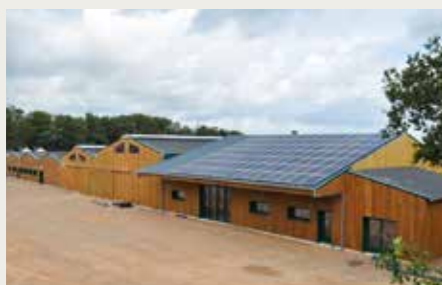
Le nouveau bâtiment laitier de La Jaillière comprend des innovations qui réduisent la pénétrabilité du travail, valorisent l'énergie solaire et améliorent le bien-être animal.
