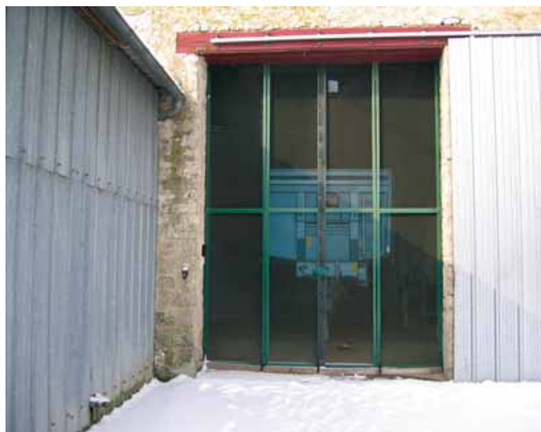
La pose de filets ou de grillages verticaux limite la présence de passereaux autour du grain.
